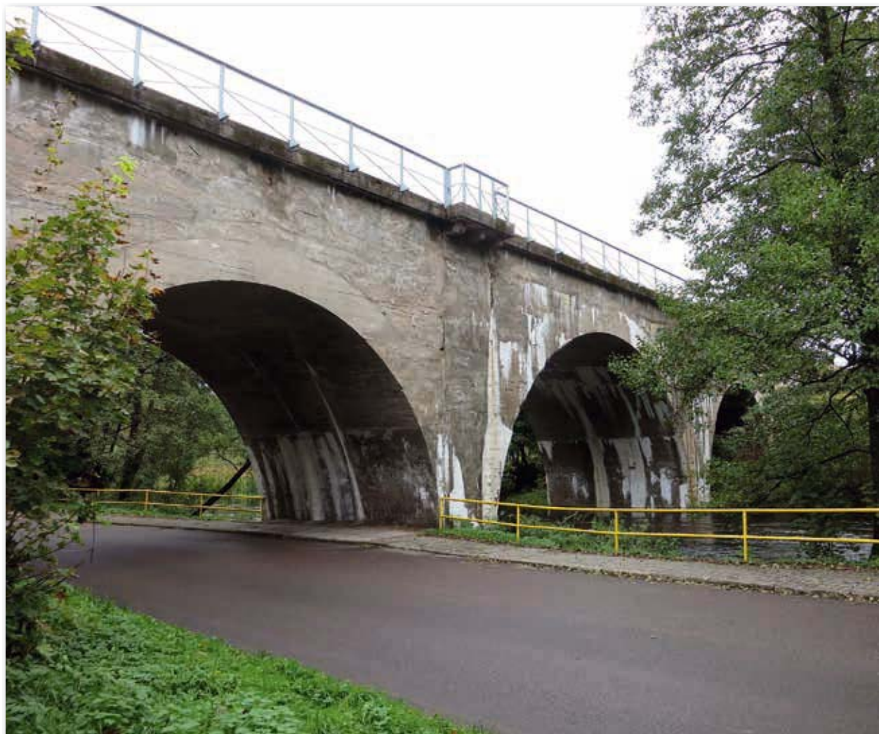
Most kolejowy nad Wdą, leżący na trasie Chojnice – Tczew
